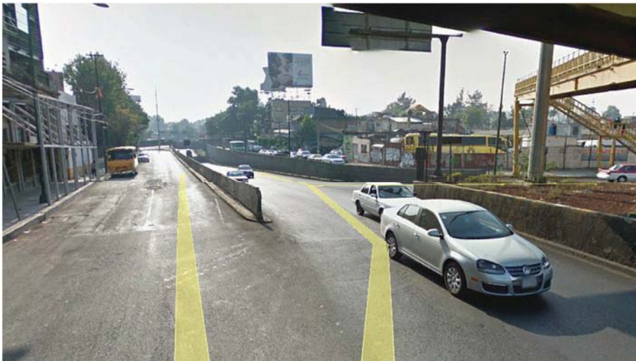
Imagen 43. Av. Observatorio Fotografía tomada de Google maps.
