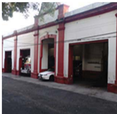
Imagen 35. Estación de bomberos.
