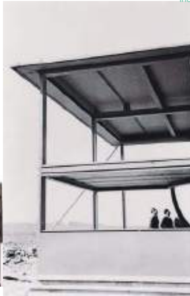
Visita de obra. Jean Prouvé Complete Works: Volumes 1, 2, 3 &
