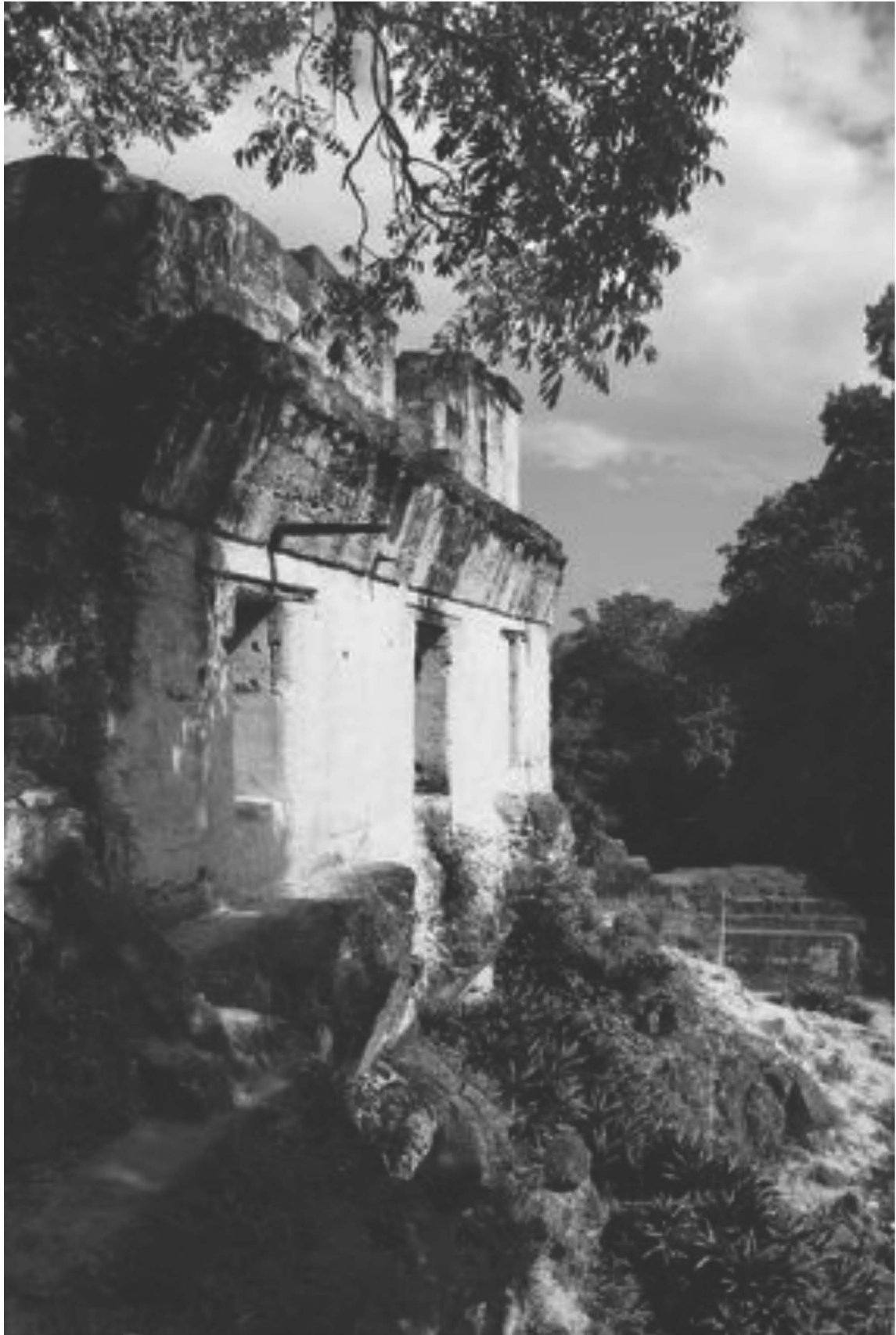
Figura 36.- Estructuras 5D-50 y 5D-52. Edificio palaciego conocido como "Palacio de los cinco pisos". Fotografía de la autora.
