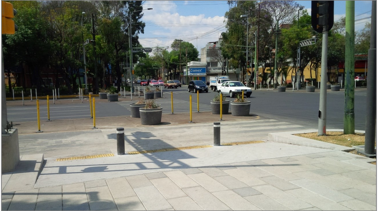
Fig. 24 Fotografía de zona norte (Av. del Taller) después de la intervención, se muestra rampas peatonales, las cuales fueron construidas a lo largo de todo el parque
