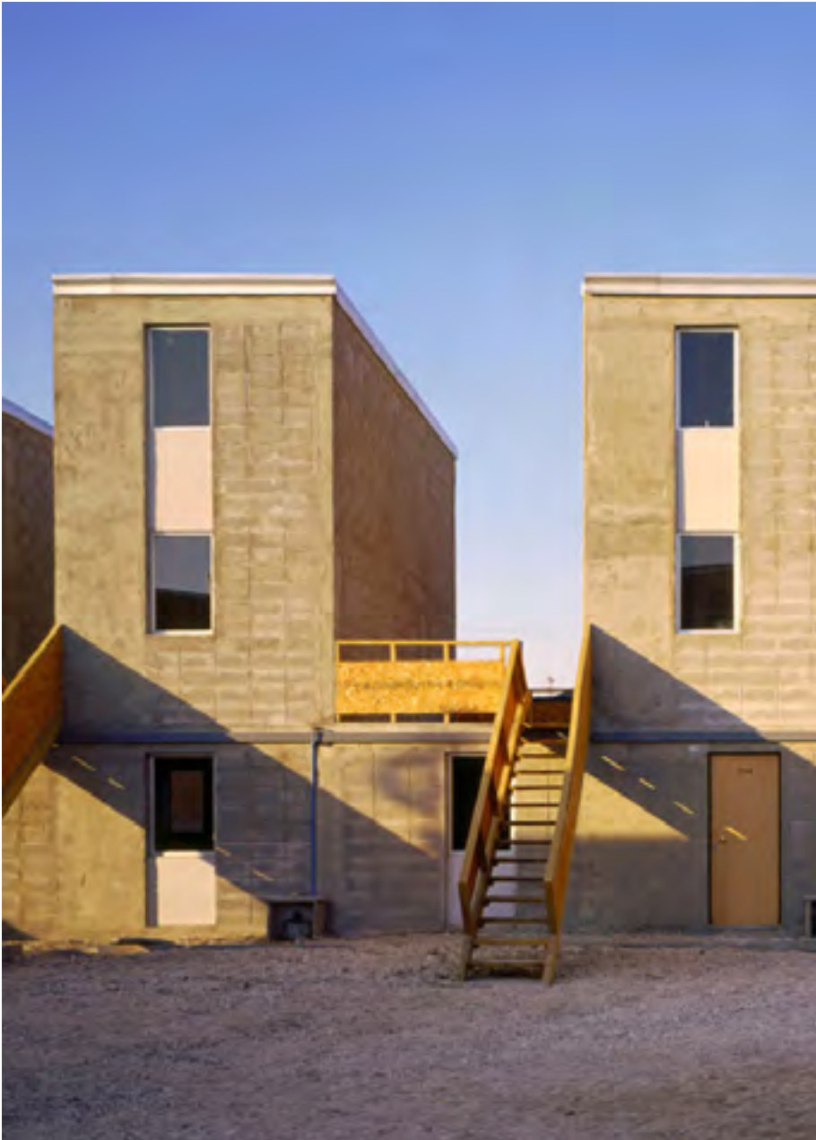
Vivienda progresiva. Iquique, Chile. Elemental Studio.
