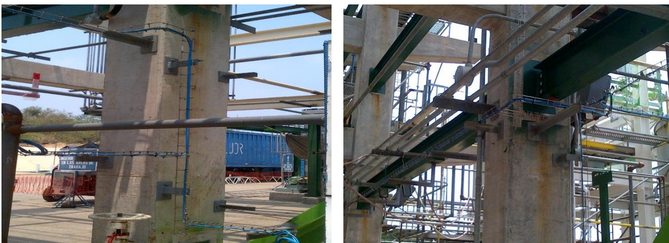
Figura 35 Cableado y montaje en charola
