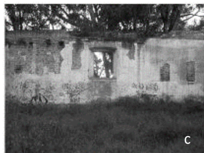
FACHADA INT OESTE
