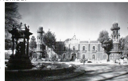
/ img.08 Casco ex- Hacienda de Chapingo en su época como escuela militar
