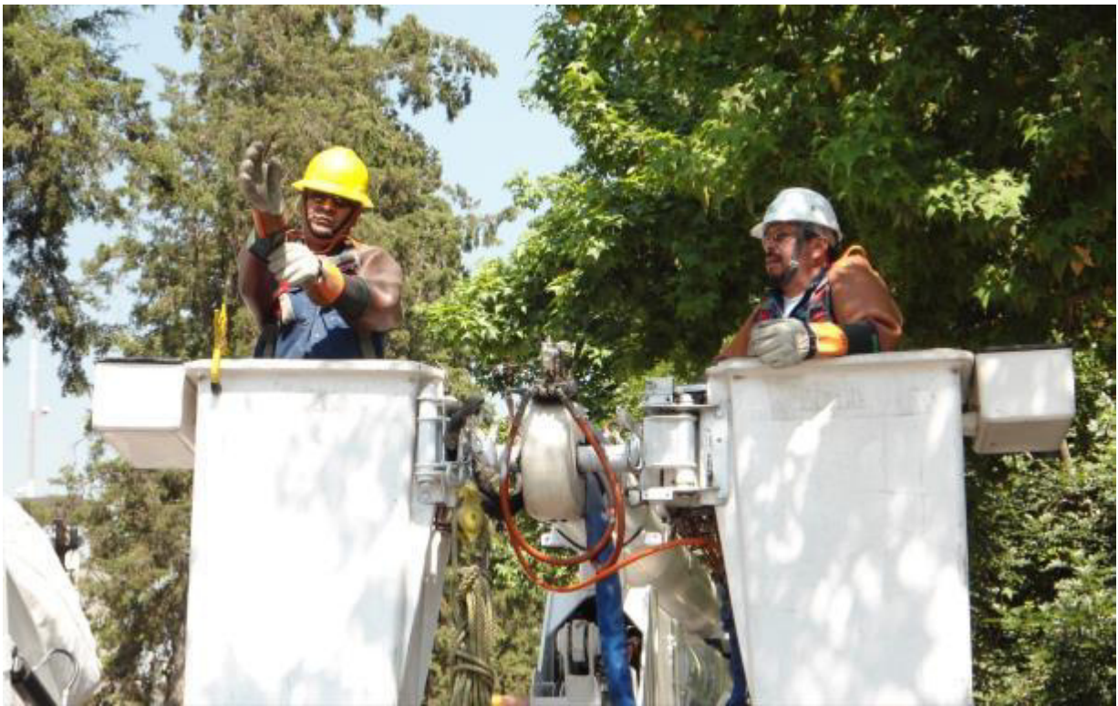
MANOS A LA OBRA.
