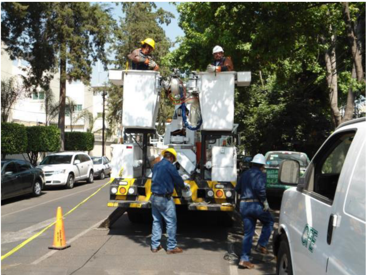
INSPECCIÓN DE MATERIALES Y HERRAMIENTA.
