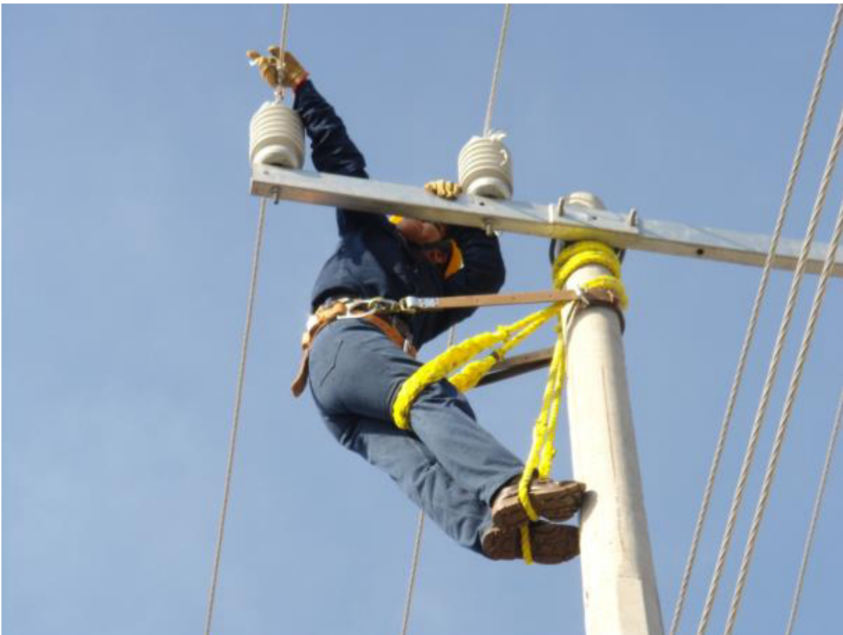
LINIERO EN EL POSTE.
