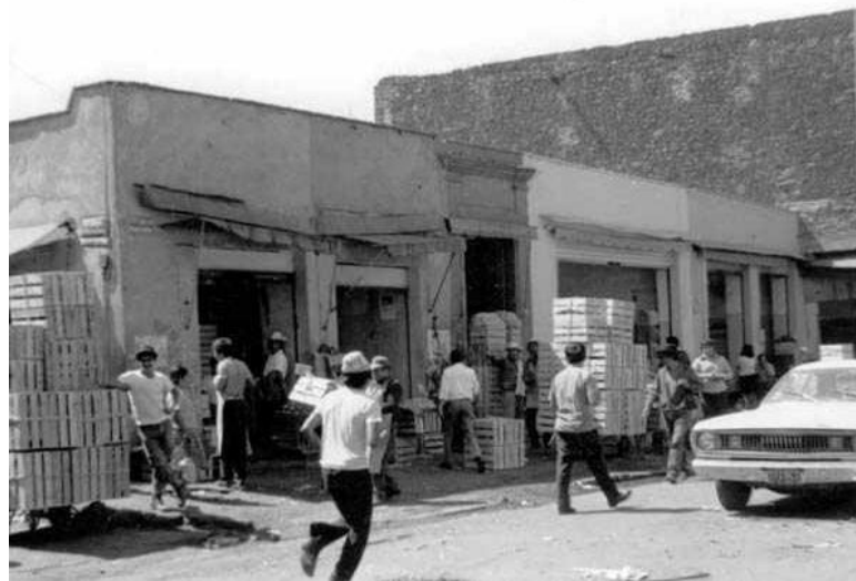
Ilustración 11. Casa en Manzanares 25, Centro D.F. Siglo XVI. Centro D.F. Fotografía de José Antonio Rojas Loa, 1970 - 1974
