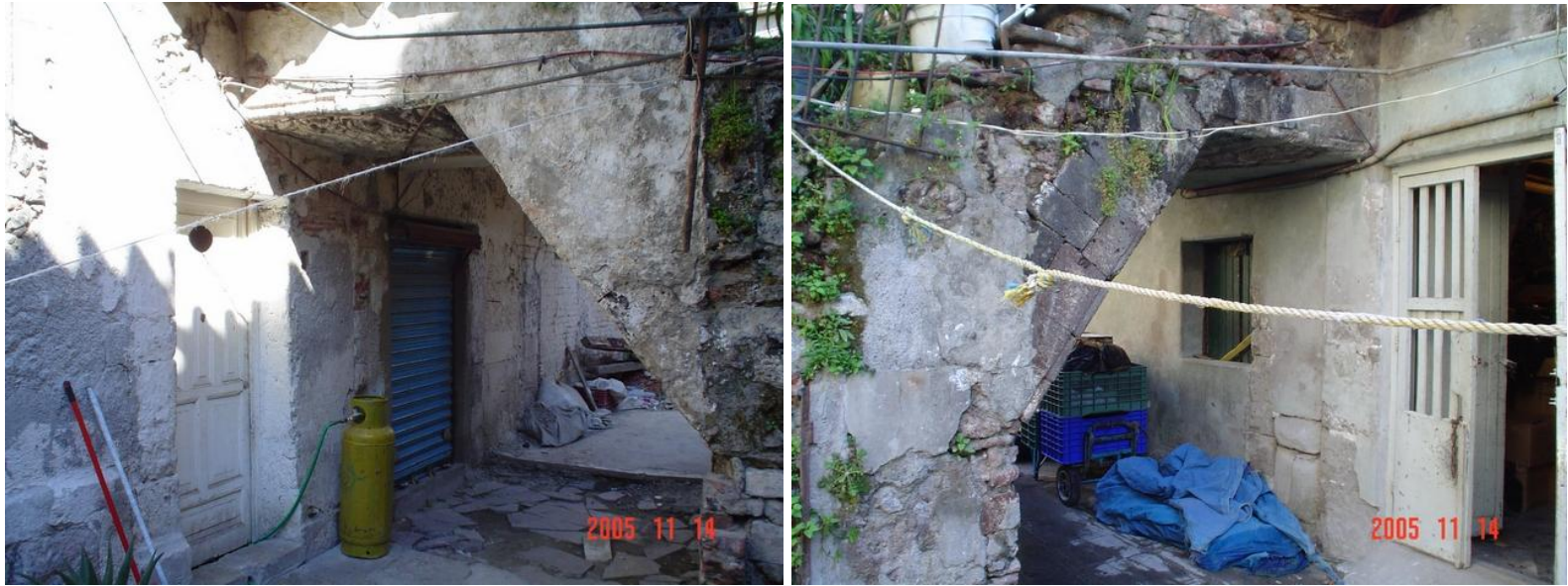
Ilustración 59. Adaptaciones bajo la escalera del primer patio.
