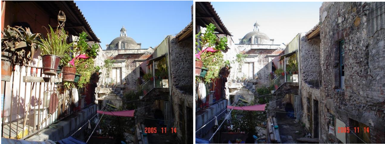
Ilustración 51. Vista interior del inmueble.
