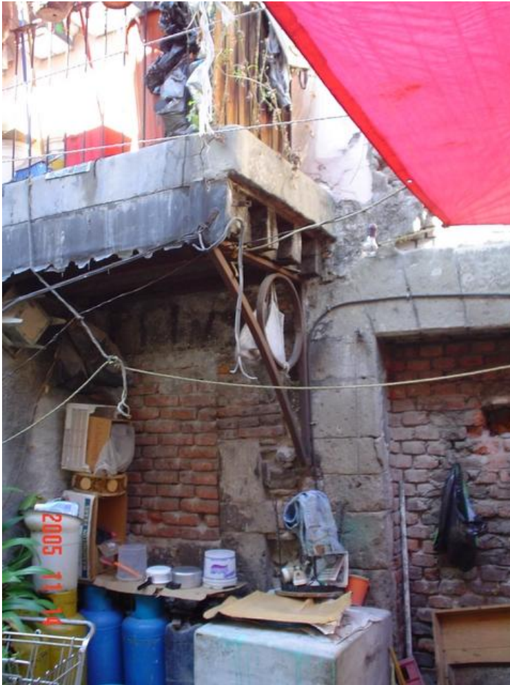
Ilustración 55. Detalle de herrería (ménsula) en corredor
