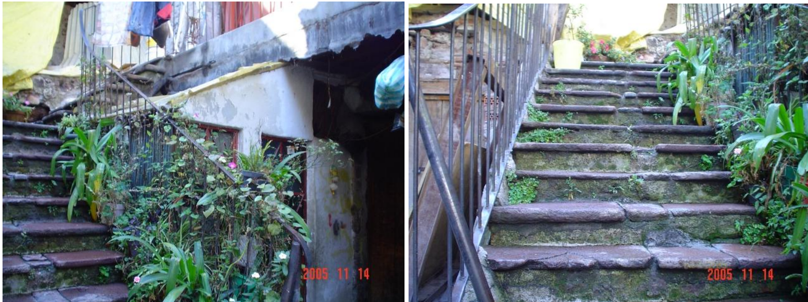
Ilustración 53. Vista de la escalera del segundo patio.
