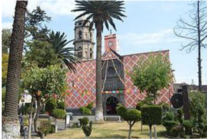
Ilustración 23. Convento de San Pedro Tláhuac. Calle Severiano Ceniceros, Tlahuac D.F. 1529-1596. Fotografía Thelmadatter, para dominio público.
