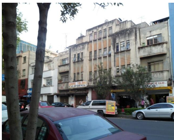
Fotografía tomada desde el predio hacia la calle Abraham González
