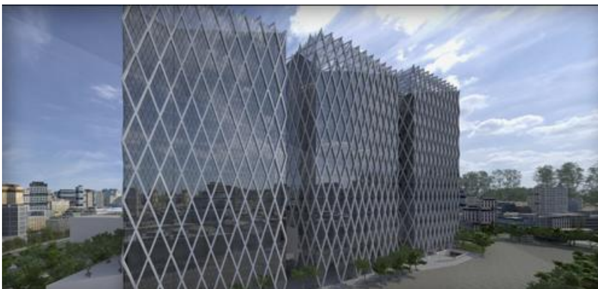
Fotografía de las torres de oficinas en conjunto de uso mixto Toreo, nuevo Parque Central. http://parquetoreo.com/wp-content/uploads/2012/04/1.jpg , recuperada en 2016.
