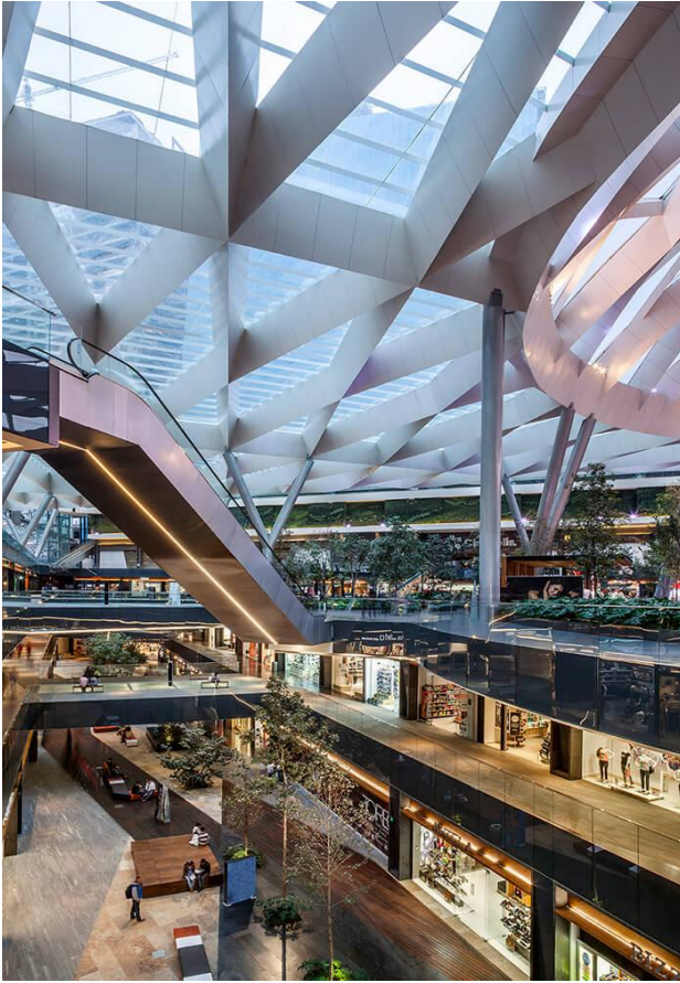
Interior del Centro Comercial, del conjunto parque central, Toreo
