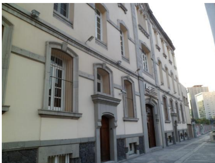
Inmueble de la Auditoría Superior de la Federación (ASF) catalogado por el INBA en la calle de Abraham González N° 82. Actualmente se encuentra abandonado. Fotografía tomada el Jueves 12 por la autora Diana Avril Aguirre Aguirre de noviembre en sitio.
