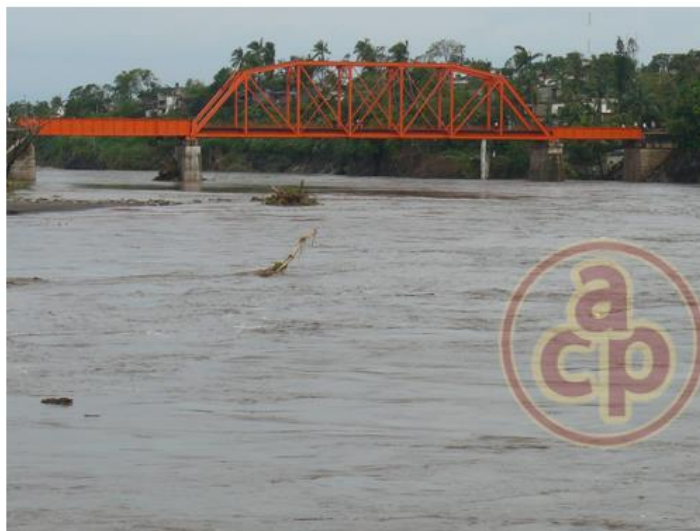
Figura 25. Puente de ferrocarril que une a La Antigua y Paso de Ovejas, el río creció 10 metros y casi llegó al ras de la base.
