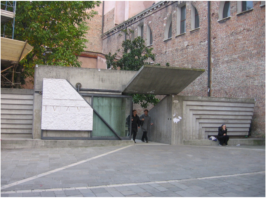
Acceso a la escuela de Arquitectura de Venecia.
