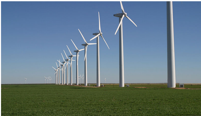
Figura 1.1. Parque Eólico en Texas, Estados Unidos.
