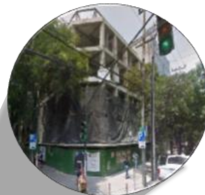
CONSTRUCCIÓN EN PROCESO
