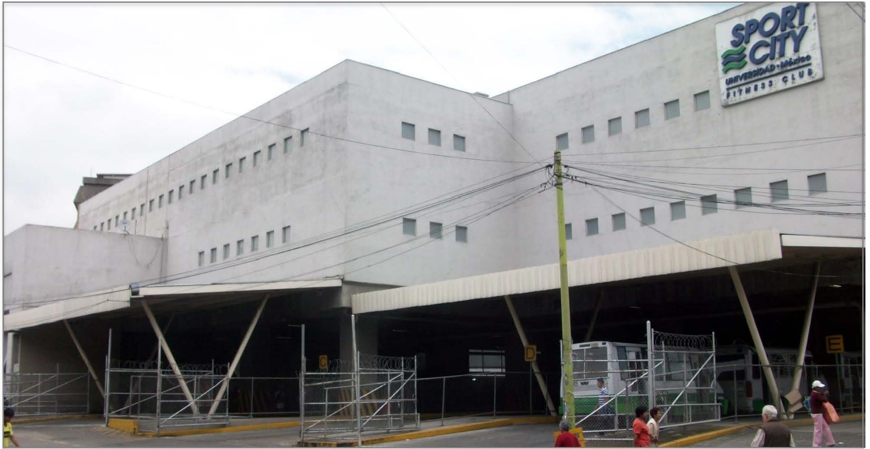
Fachada CETRAM Zapata
