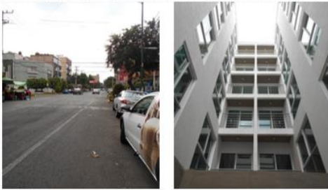
ENTORNO / FACHADA INTERIOR
