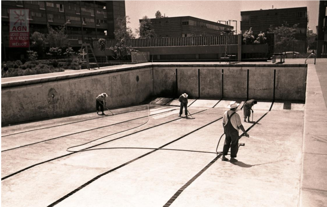
Figura 27: el mantenimiento de la alberca del CUPA era realizado semanalmente por el personal contratado por la Dirección de Pensiones Civiles. AGN, Fondo Hermanos Mayo, Sobre, hmcr 1738. Tema, Multifamiliar, imagen 015
