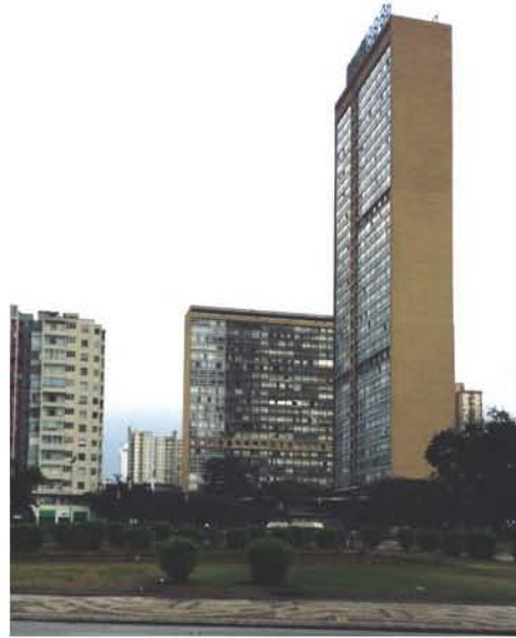
Figura 53: conjunto Juscelino Kubistchec (JK) localizado en la Ciudad de Belo Horizonte, capital de Minas Gerais de Brasil. Fotografía del auto, septiembre de 2015
