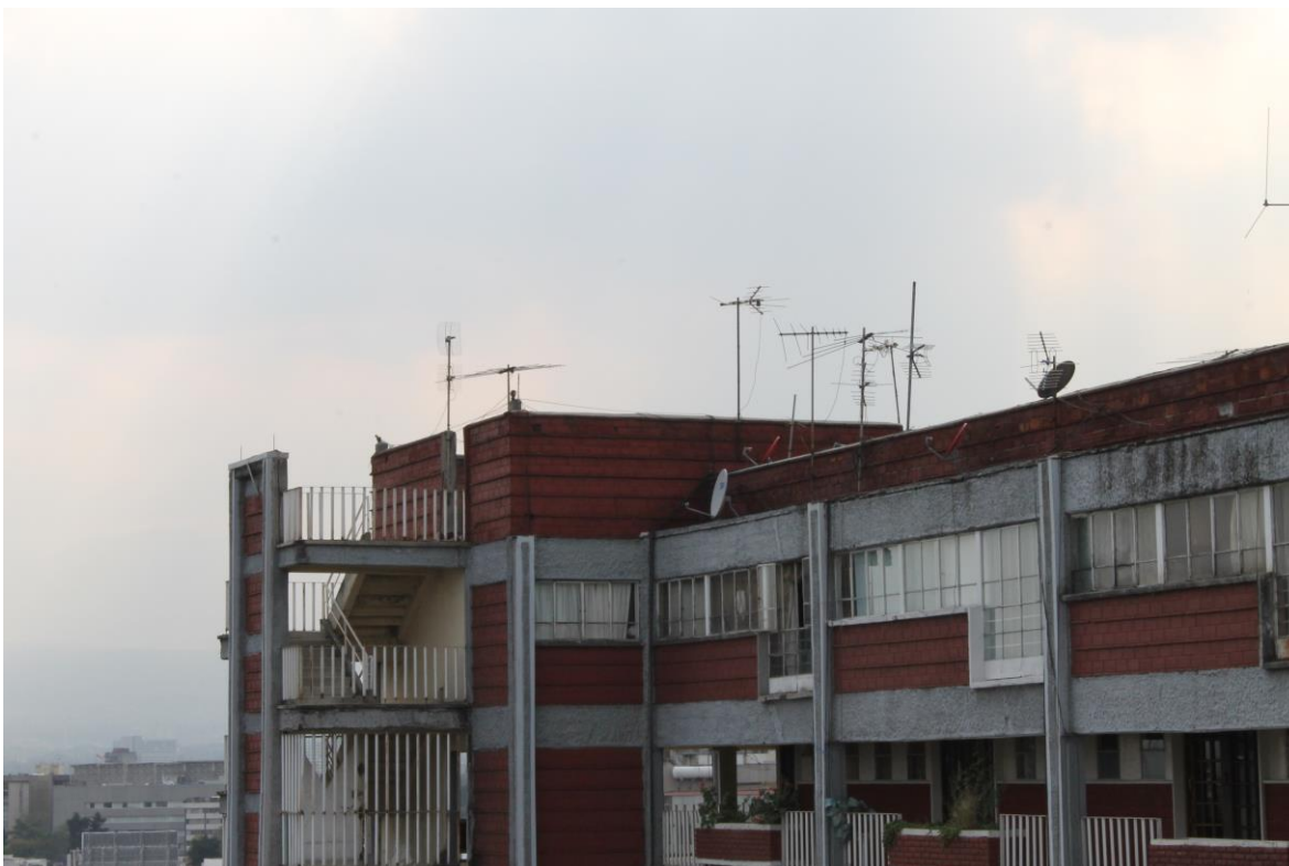
Figura 37: refuerzos perimetrales de acero en columnas de torres de departamentos, estos fueron los últimos trabajos que el ISSSTE financió en el conjunto. Fotografía del autor, enero de 2013
