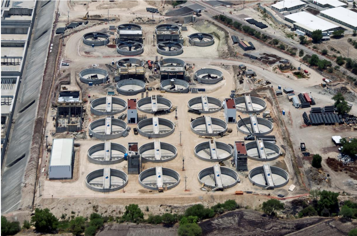
Figura 4 Tanques clarificadores primarios.
