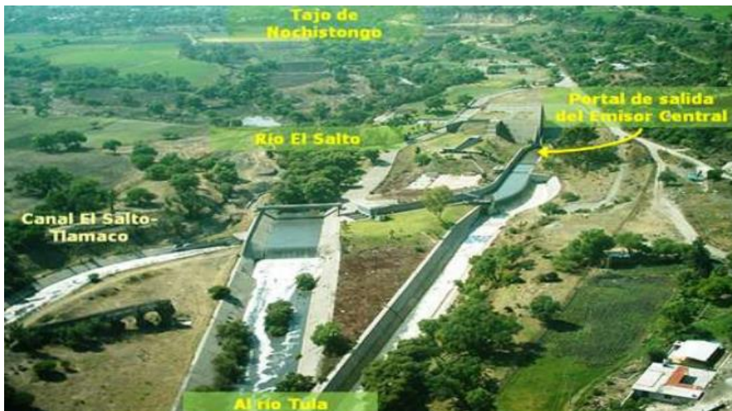
Figura 1. Portal de salida de los emisores de aguas residuales
