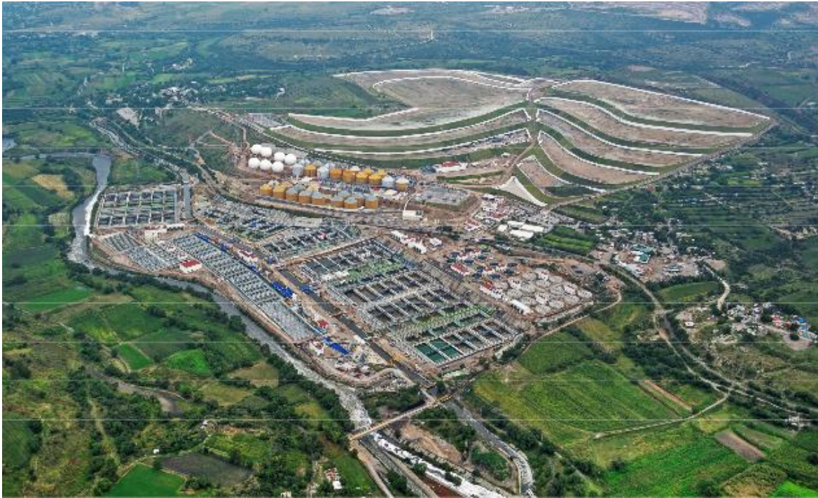
Figura 3. Vista General de la PTAR Atotonilco.
