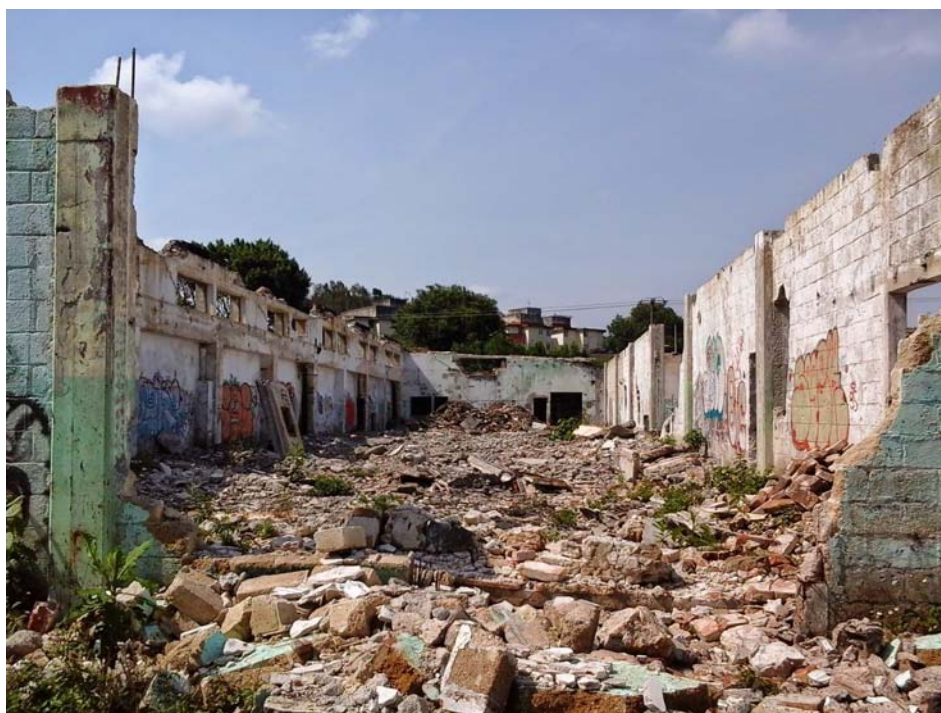
Imagen 18. Entre vecinos y 50 camiones del ayuntamiento (a petición de los vecinos) ayudaron a retirar todo el escombro que se encontró, ya que la fábrica antes de la intervención había sido saqueada. Autor: Francisco De Luna
