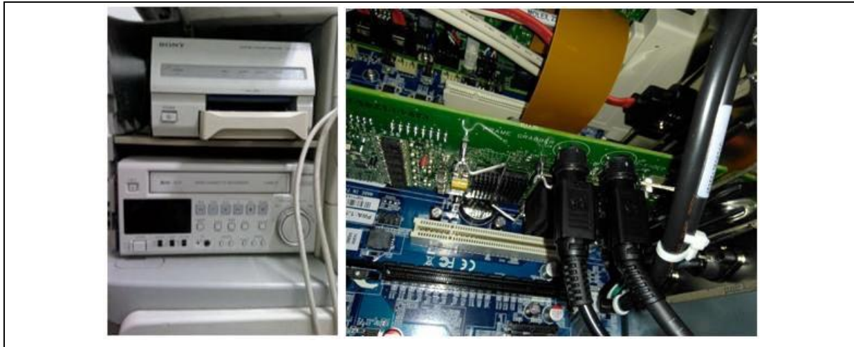
Figura 7.6.7 Revisión de periféricos y conectores
