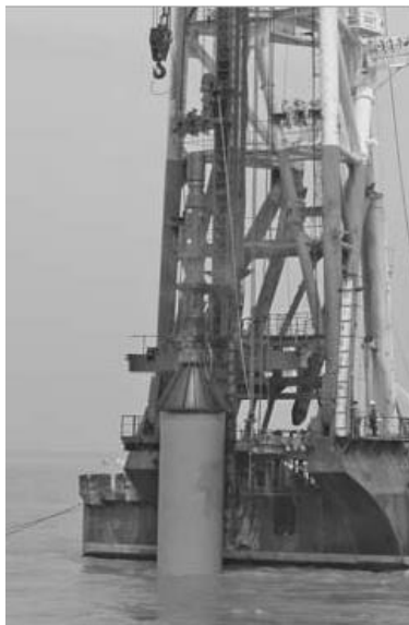
Figura 5-15 Martillo de hinca tipo en operación. (Delmag DB Chin E).
