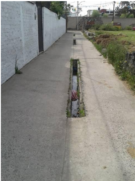
3.13.a. Desagüe colectivo de agua gris, Ampliación Caltongo
