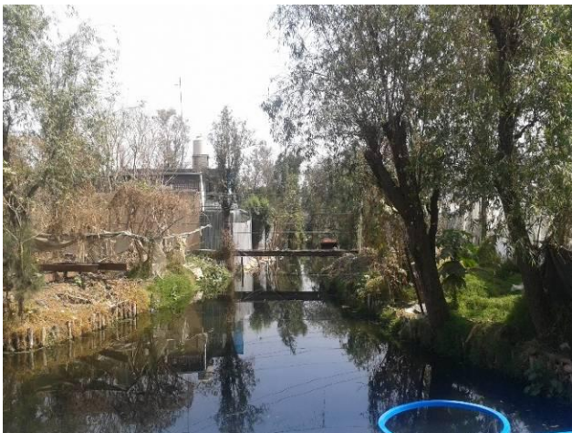
3.26.b Puente privado construido con cemento y metal, Barrio Caltongo
