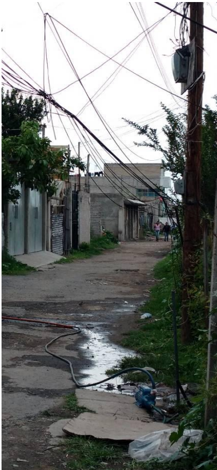
3.4.a. Toma comunitaria de agua potable, Recodo de Caltongo
