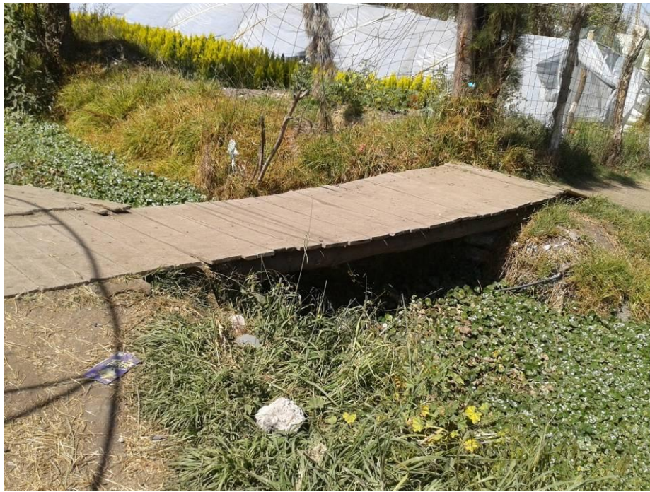
3.26.a. Puente colectivo construido con madera, Barrio Caltongo
