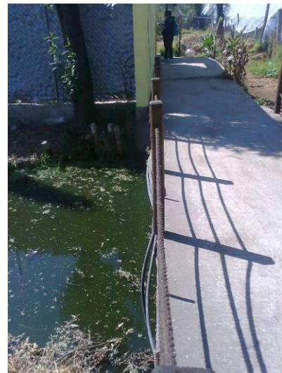
3.26.c. Puente colectivo construido con cemento, metal y madera, Barrio Caltongo
