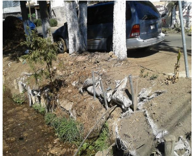
3.3.b. Costales en avenida Nuevo León, Barrio Caltongo
