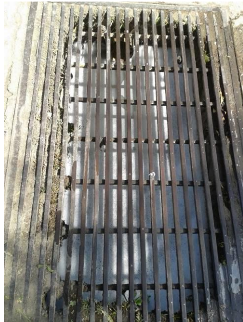
3.13.b. Desagüe colectivo de agua gris, Ampliación Caltongo
