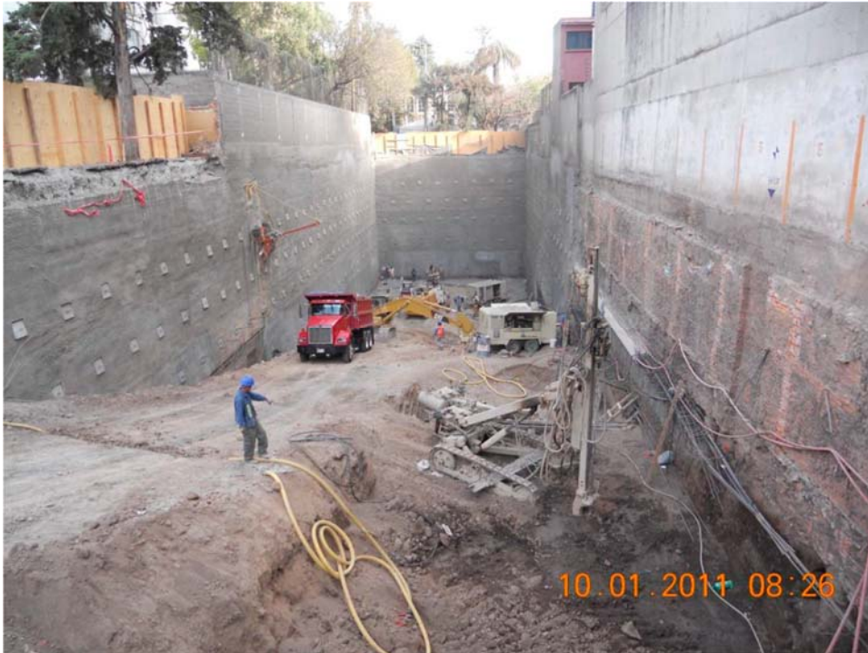
Excavación y trabajos de concreto lanzado
