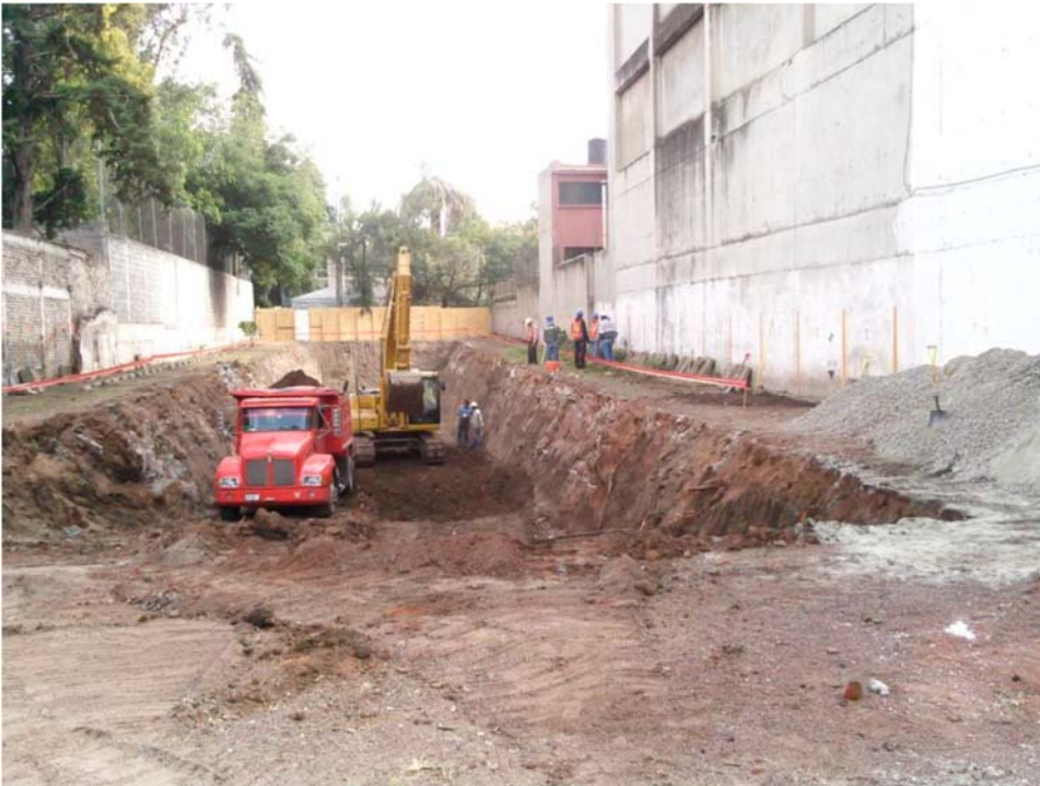
Inicio de los trabajos
