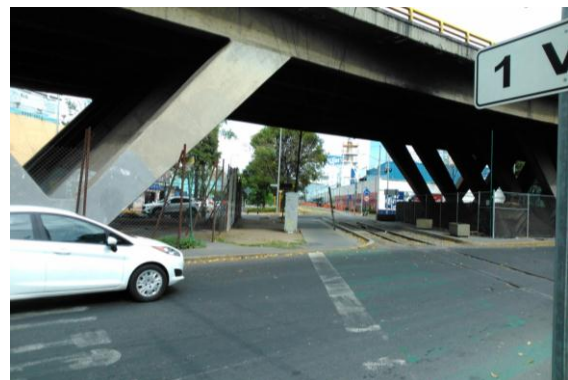
Imagen 29 Bajo puente Río San Joaquín cruce con Ferrocarril de Cuernavaca.
