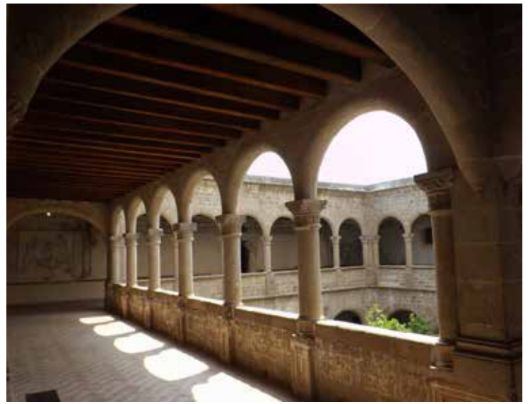
Figura 1.29. Claustro mayor, planta alta.
