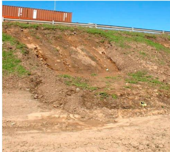
Figura 4.3 Falla por deslizamiento superficial (Matteis, 2003)
