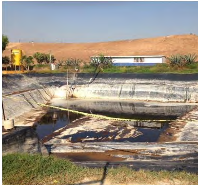
Figura 3-4. Laguna de lixiviados del relleno sanitario de Tlalnepantla.
