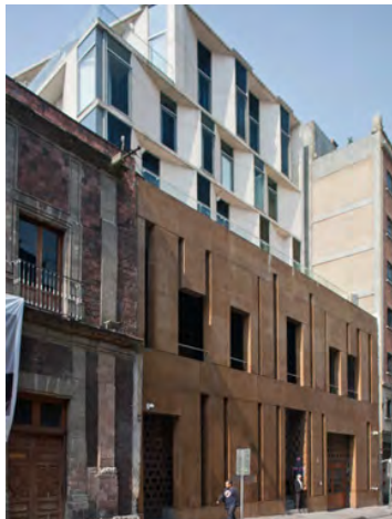
INTERVENCIÓN EN FACHADA DE LA CALLE DONCELES.
