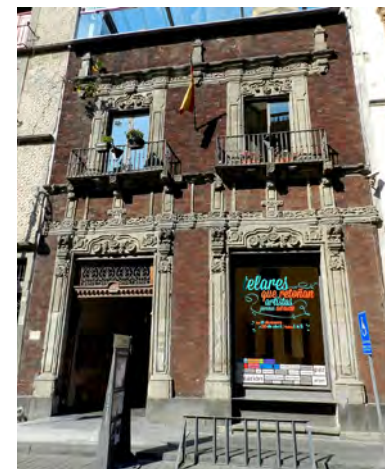
INTERVENCIÓN EN FACHADA DE LA CALLE GUATEMALA.
