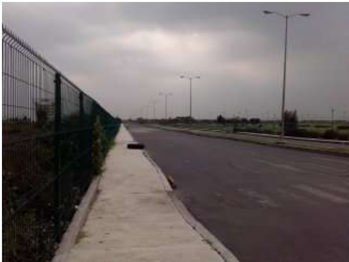
Figura 46: Fotografía que muestra las luminarias para alumbrado público presentes. Fuente: Autoría propia (2015)
