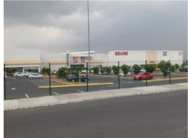
Figura 41: Fotografía a nivel de calle con vista al sur del predio. Fuente: Autoría propia (2015)
