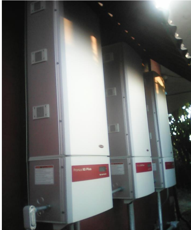
Fig. 3.8 Inversores IG Plus V 10.0-3 Delta del sistema
