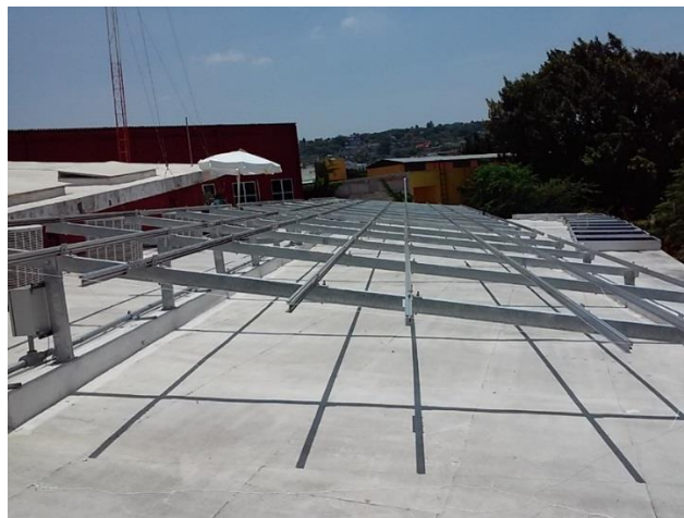
Fig. 3.4 Montaje de la estructura de los módulos fotovoltaicos
