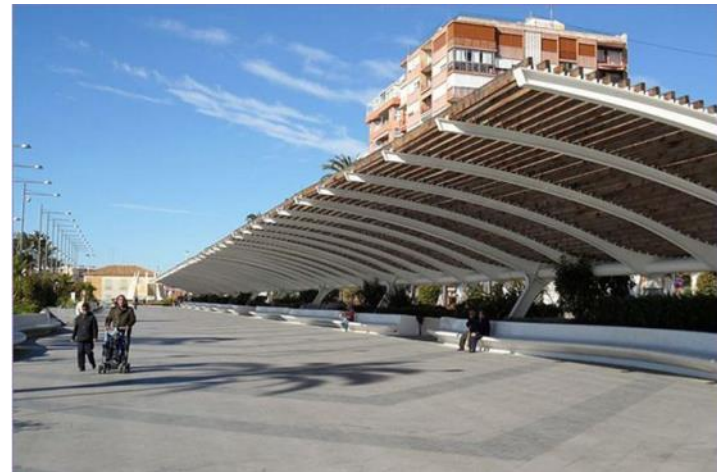
Imagen 3.4 (Pérgolas en voladizo).
