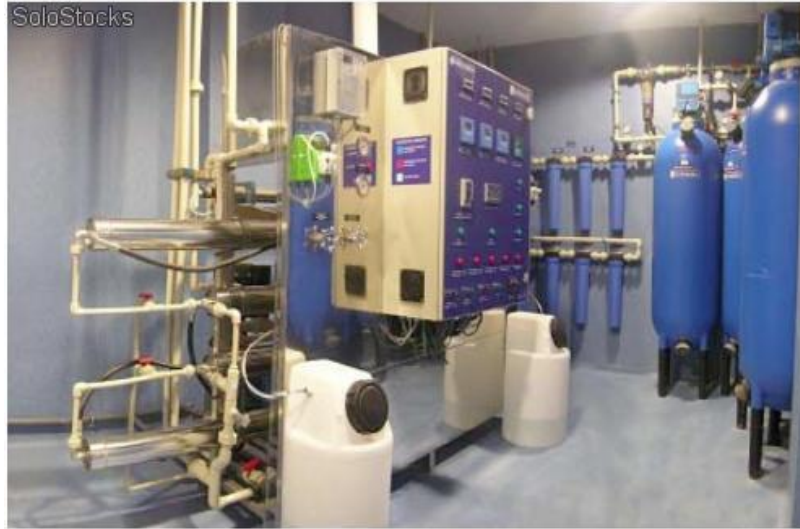
Fotografía (7) Plata de tratamiento de agua para la hemodiálisis. plantadeagua.blogspot.mx .
