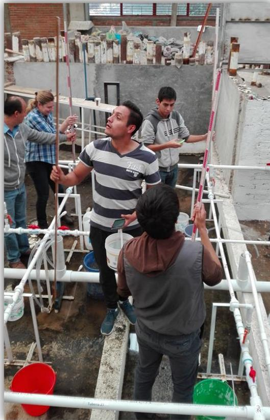
Fotografía 9, Ultima prueba (Medición de las presiones)
