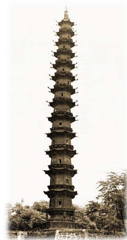
▼ Imagen 1.15. Pagoda Yu Quan, construida con hierro fundido en 1061 en Dangyang (Hubei), de 13 metros de altura. La industria de hierro (y acero), fue nacionalizada desde la dinastía Han en el 119 a. C.
