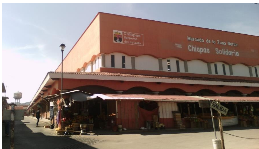
Figura 3.34 Fachada del Mercado de la Zona Norte
