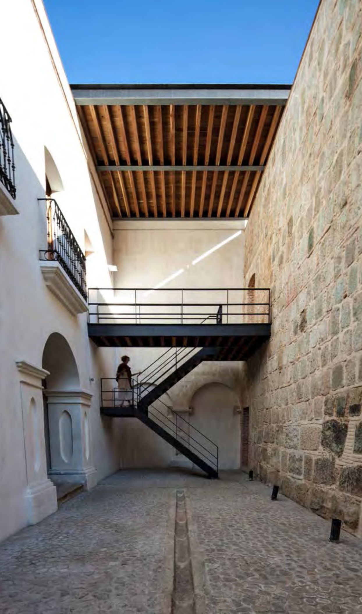
Fotografía que muestra la clara integración entre los materiales históricos y contemporáneos en el Centro Cultural San Pablo. Fotografía de Sandra Pereznieto.
