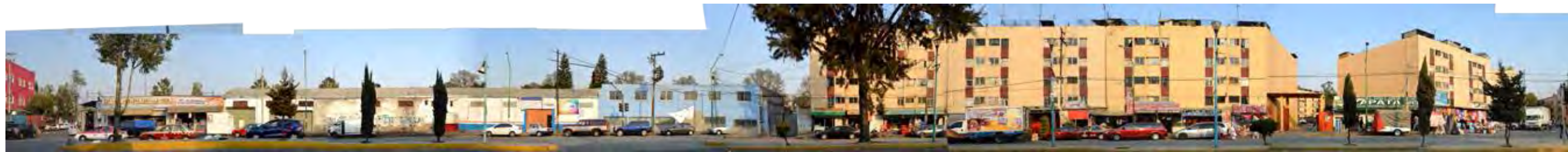
8. Vista Oriente de Ferrocarril de Cintura
