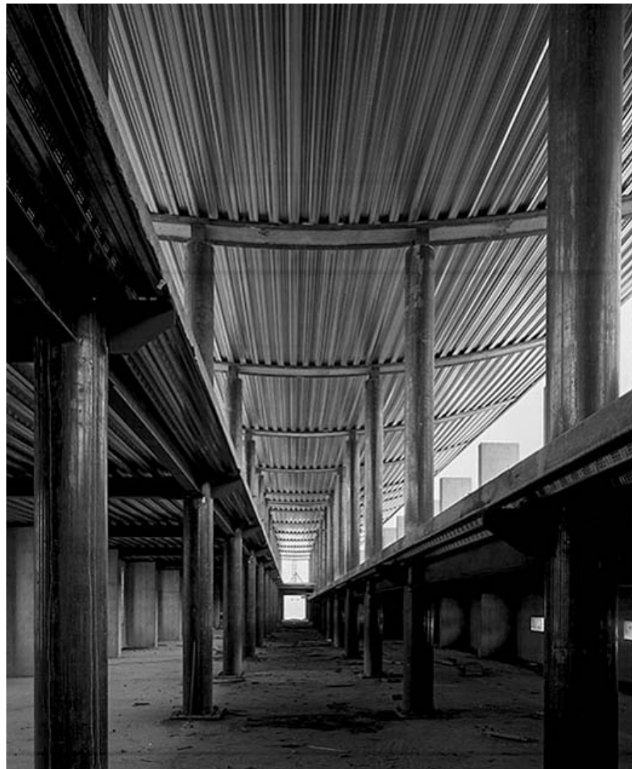
Interior de la nave principal durante el proceso de construcción. Fotografía del Archivo TAX.
