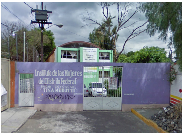
Fachada exterior del CIAM "Tina Modotti"
