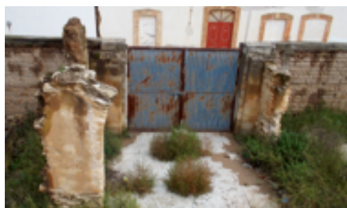
Imagen 107. Vista de los muro de soporte de graderías, Pozos, Gto. Fuente: Colección del autor.
