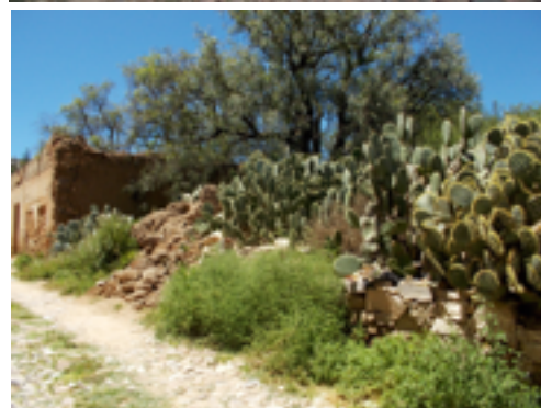
Imagen 103. Muro de adobe siendo reemplazado por con block de cemento, Pozos, Gto.
