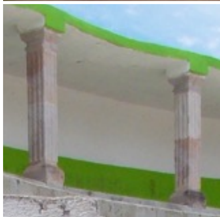
Imagen 81 (superior) vista del tendido con cubierta soportada por columnas de cantera labradas.
