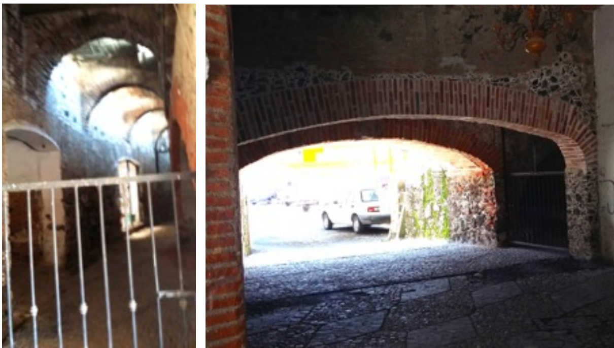
Imagen 76 (Izq.) Pasillo inferior del tendido que recorre la circunferencia externa del edificio, en la plaza de toros "La Macarena" en Salvatierra, Gto.
