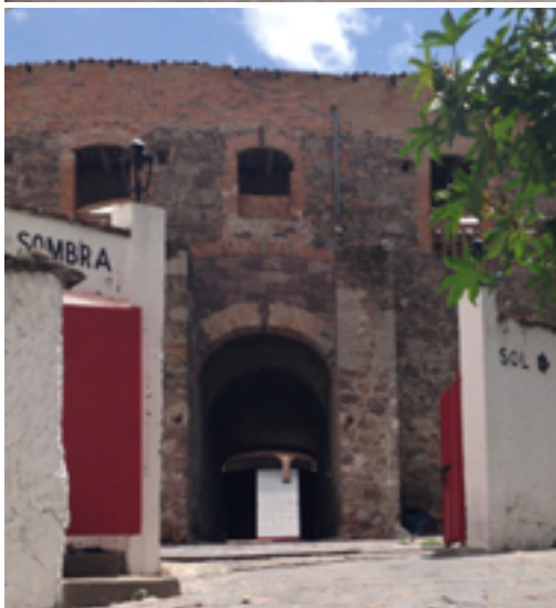
Imagen 58 (superior). Gradería de la Plaza Oriente, San Miguel de Allende, Gto. Imagen 59 (inferior izq). Dirección de los accesos a cada zona (sombra o sol).
