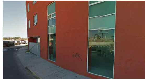
EDIFICIO A DEMOLER
