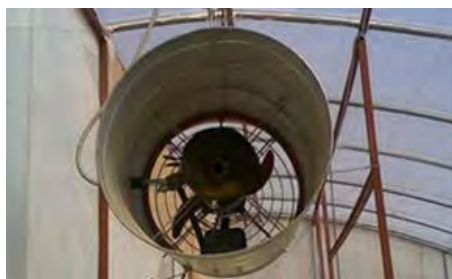
Figura 3.2 Etapa de calefacción por medio de calefactor de gas.
