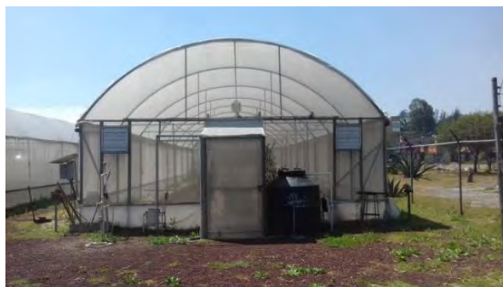
Figura 2.1 Parte frontal del invernadero
