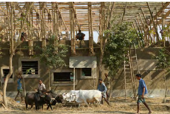
Proceso constructivo de escuela, mano de obra local.
