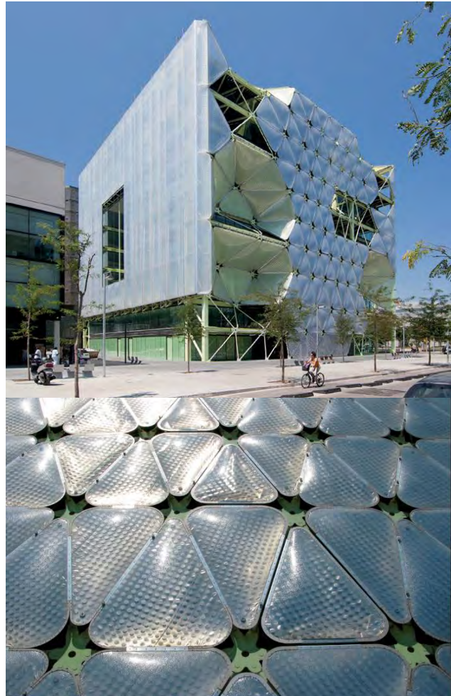
Figura 13. Media Tic. Y sus almohadillas de ETFE. Recuperado de Fuente: http://www.ruizgeli.com/projects/built/media-tic
