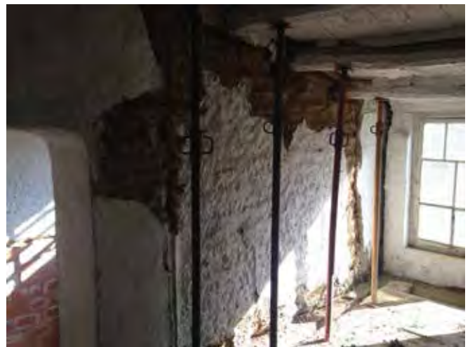
v figura 63. Muro de tapia para extracción en Gelida, Cataluña.
