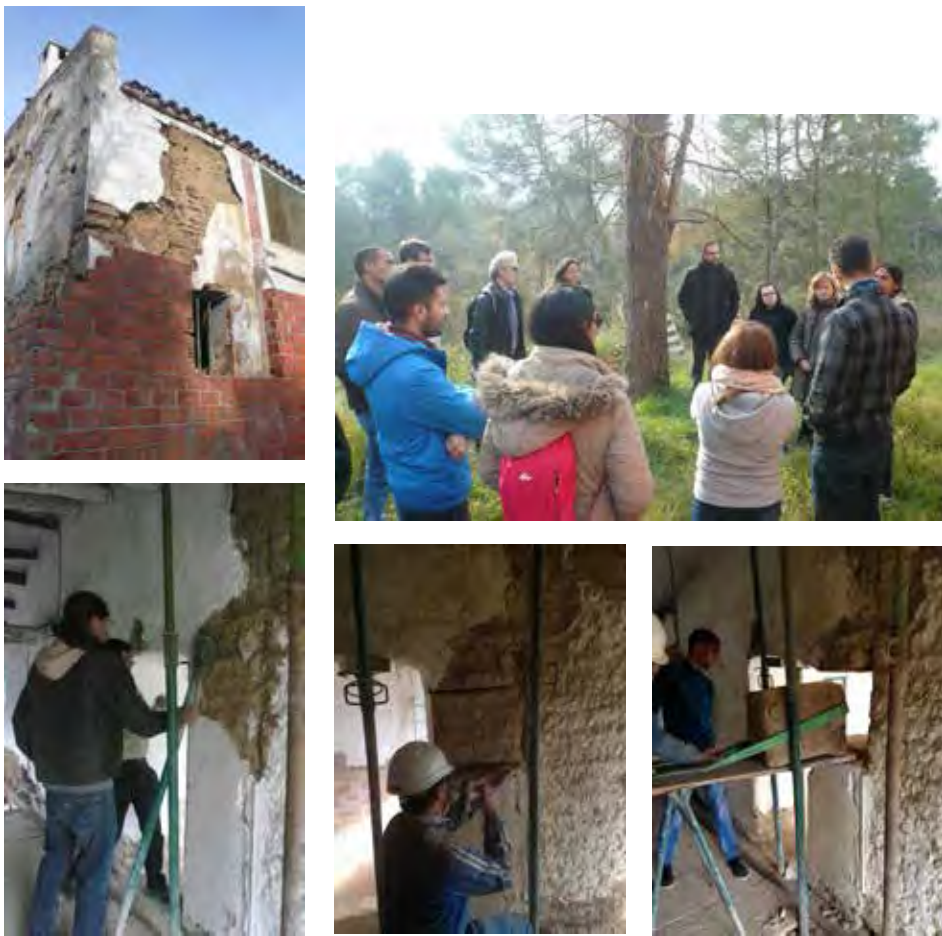
^ figura 65. Serie de imágenes del procesos que se llevo acabo para la extracción del muro de tapia.
