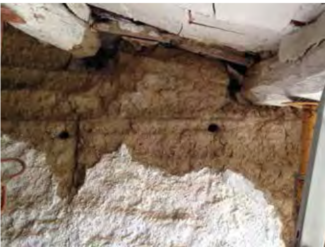
v figura 62. Muro de tapia para extracción en Gelida, Cataluña.
