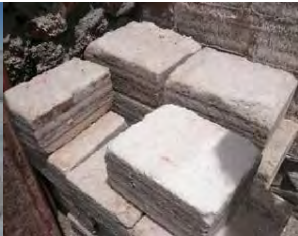
^ figura 4. Ladrillos hechos a base de sal, salar de Uyuni, Bolivia.
