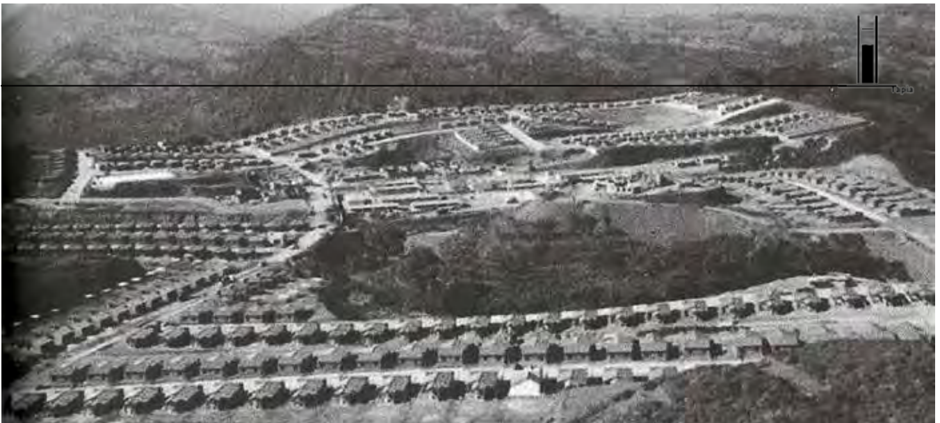
^ figura 27 Vista aérea de la ciudad rural Nuevo Juan de Grijalva, Chiapas.
