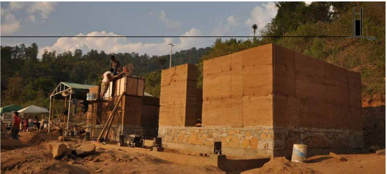
^ figura 7. Construcción a base de la técnica de tapia, en Pensamiento Liberal Mexicano, Zaachila, Oaxaca.
