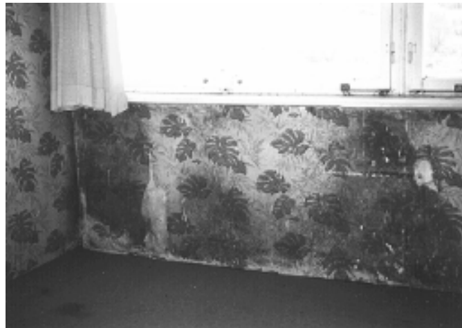
Figura 1.7 fotografía del área analizada; extraída del artículo “Problems in failure analysis in Building pathology” (Molnárka, 2000)
