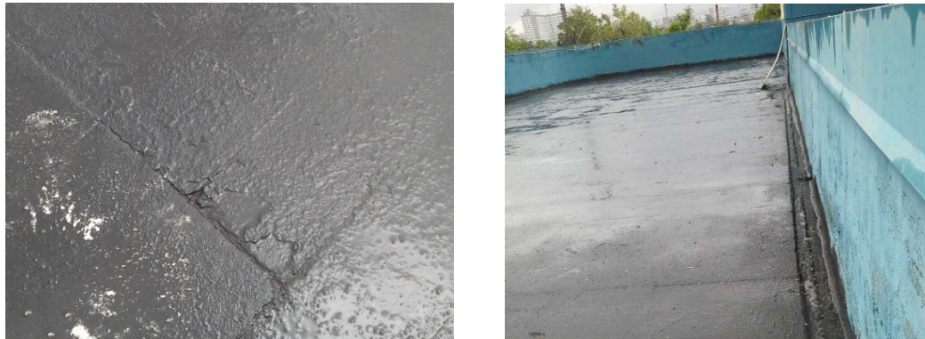
5.28 Impermeabilización en terraza
