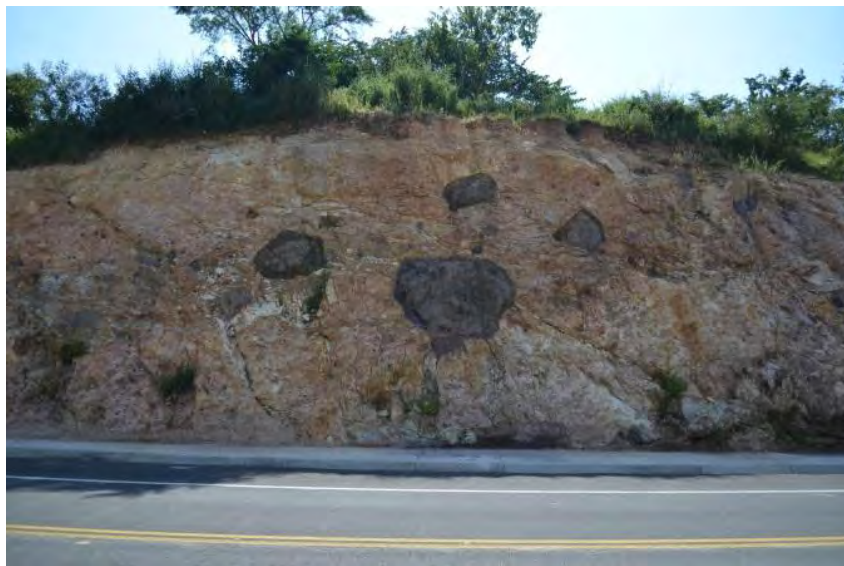
Figura 8. Ignimbrita perteneciente al Súpergrupo Volcánico superior de la SMO, se pueden observar líticos de gran tamaño pertenecientes a pulsos andesíticos previos probablemente del Complejo Volcánico Inferior. Carretera 40D Durango-Mazatlán Mpio. Concordia. Fotografía Roberto Maldonado.
