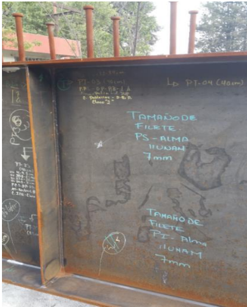
Fotografía N.- 4 Tamaño del filete dovela metálica
