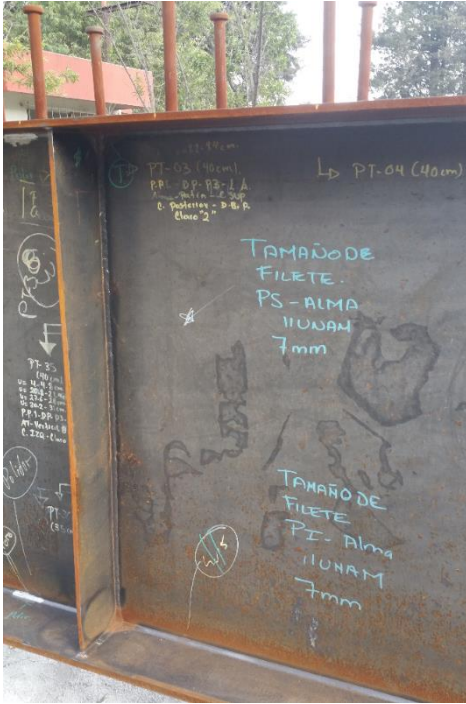
Fotografía N.- 3 Tamaño del filete dovela metálica
