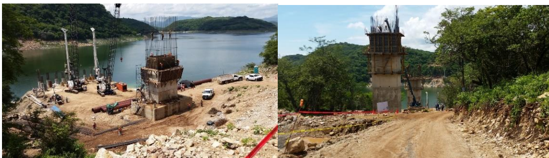
Fotografía N.- 2 Armado de Pilas puente Concordia 2016
