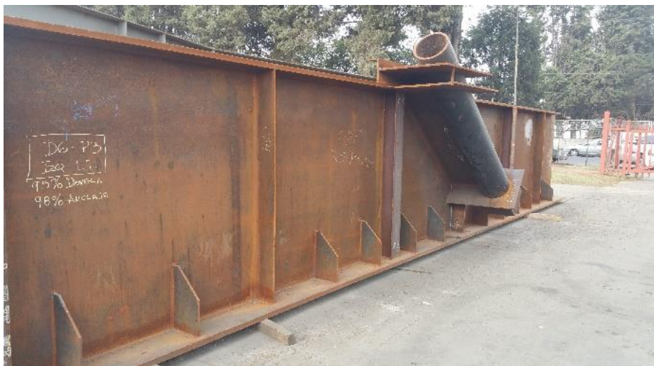
Fotografía N.- 1 Dovela metálica
