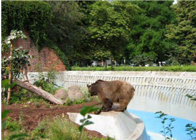
Talud como contención de albergues. (Foto: guiadealemania.com)
