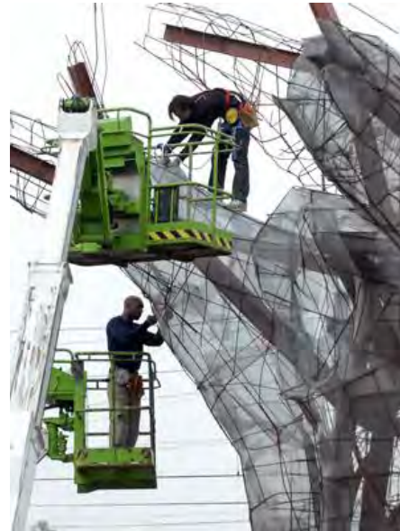
Diseño y construcción de estructuras para ambientación de zoológicos por Houthoff Zoo design. (Foto: Houthooff projects).
