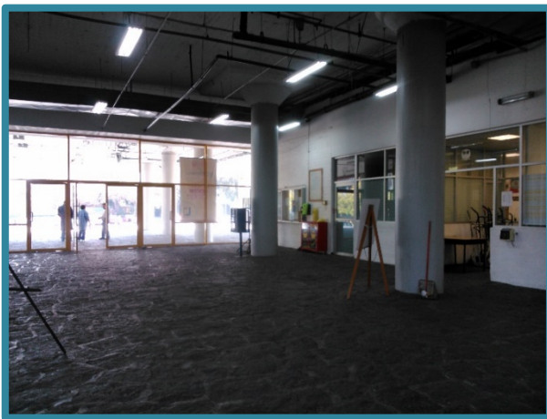
Fig. 10 Vestíbulo de edificio A.
