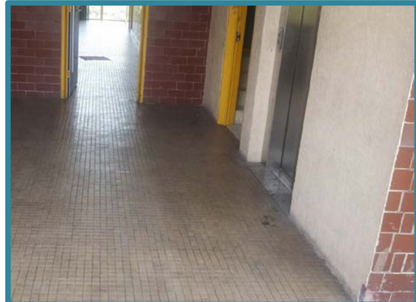
Fig. 24 Acceso del elevador en el primer nivel del edificio A.
