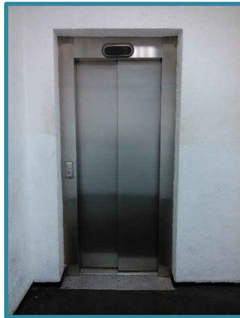
Fig. 23 Acceso del elevador en la planta baja del edificio A.
