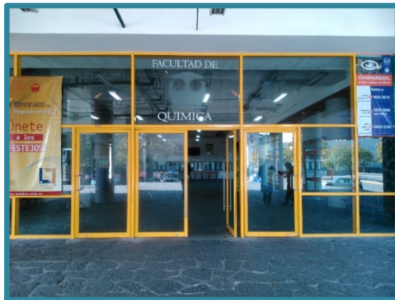
Fig. 19 Acceso principal del edificio A
