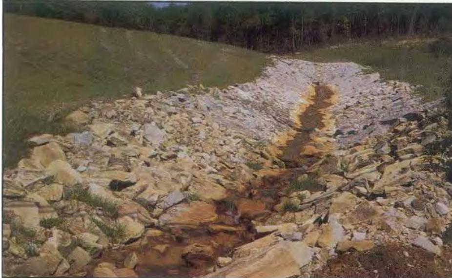
Figura 4.6. Porción de un canal abierto de caliza. (Fuente: Ziemkiewicz, et al., 1997)
