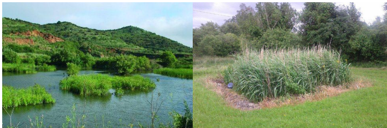
Figura 4.- Comparativa visual entre un humedal artificial de flujo superficial (FWS) y uno de flujo Subsuperficial (SFS). En esta imagen se puede apreciar como los dos tipos de humedales artificiales se pueden distinguir visualmente de manera fácil; mientras uno podría fácilmente confundirse con humedal natural (FWS), el segundo (SFS), colocado en campo abierto se mezcla como un simple conjunto de plantas, en este caso carrizos.
